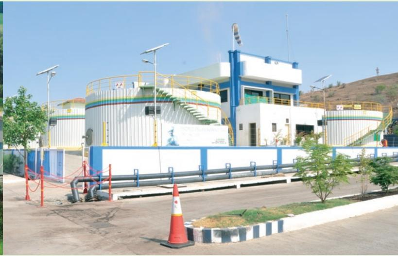
Wege zur effizienten Biogasanlage: eine nachgerüstete Hydrolysestufe (links) oder eine moderne zweistufige Hochleistungs-Biogasanlage (rechts).
