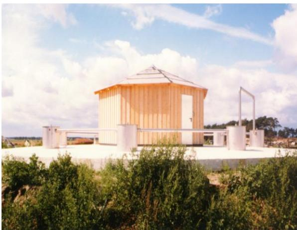
*Der Fermenter ist vollkommen im Boden eingelassen und fügt sich sehr gut in die betriebliche Umgebung ein. Im Schutzhäus auf der Fermenterdecke ist die komplette Gasaufbereitung untergebracht.*
