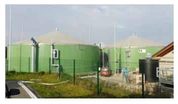
Die Biogasanlage Gera, im Ortsteil Aga, wurde im Jahr 2011 als typische NaWaRo Biogasanlage, mit Hauptund Nachgärer, sowie Gärproduktlager, errichtet.
